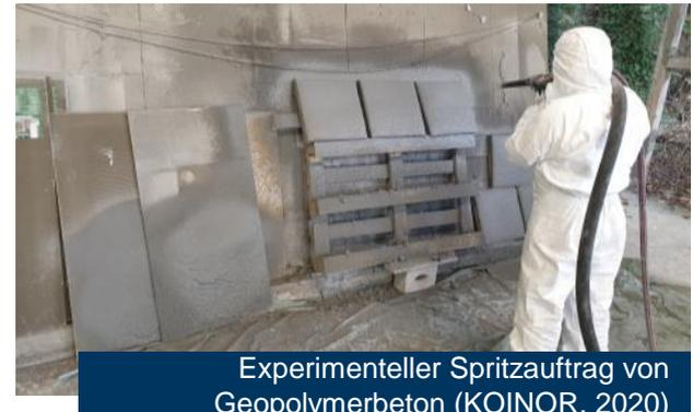
Experimenteller Spritzauftrag von Geopolymerbeton (KOINOR, 2020)
