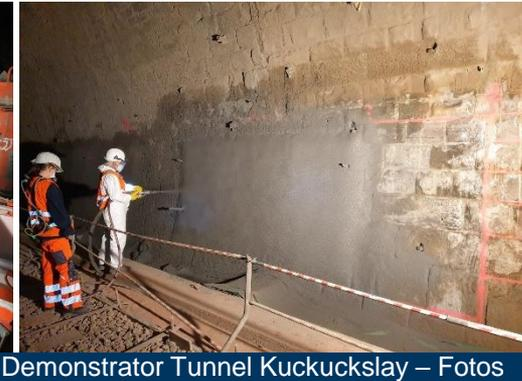
Demonstrator Tunnel Kuckuckslay – Fotos des Spritzbetonauftrags (KOINOR, 2021)
